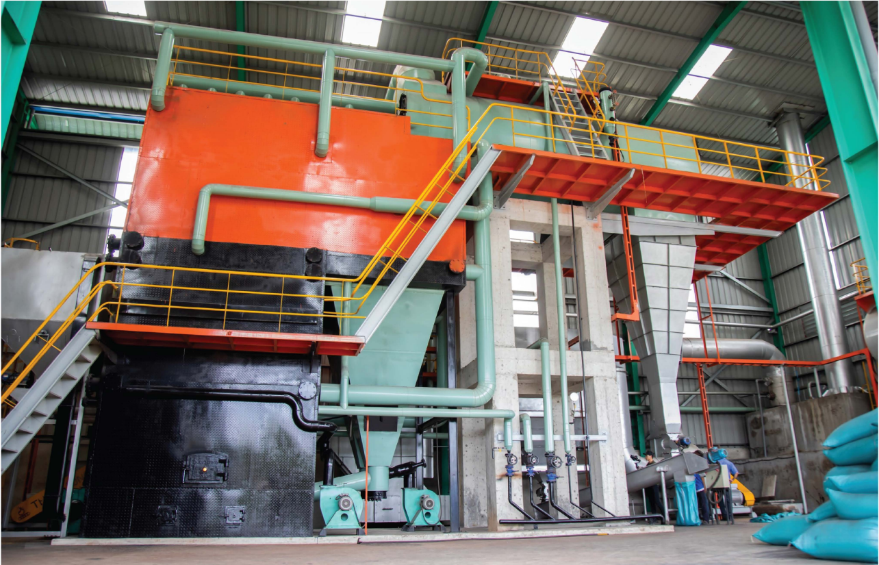
Cụm bán hơi công suất 10 tấn hơi/giờ CN1 - CTY TNHH SX TM DV XP PHÚ CƯỜNG - H. Củ Chi, TP. Hồ Chí Minh
